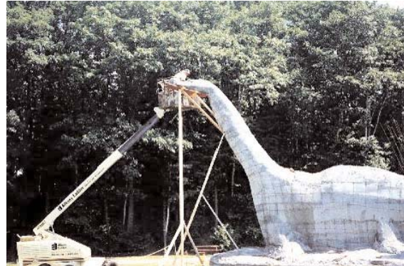
Thi công một công trình điêu khắc bê tông
